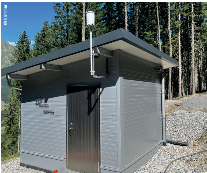
Die Einhausung des Maschinenhauses wurde mit Fertigteil-Edelstahlpaneelen erstellt.
